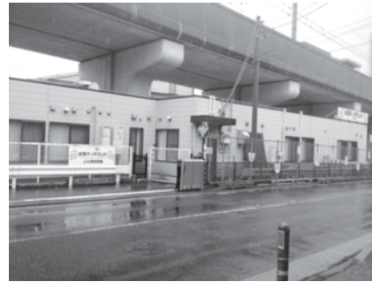
写真② 電車高架下の保育園
